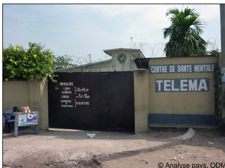
Photo 20 - Centre de santé mentale Telema
